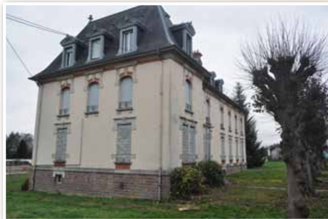
La «villa du colonel», qui va être entièrement réhabilitée, deviendra une résidence pour personnes âgées.
