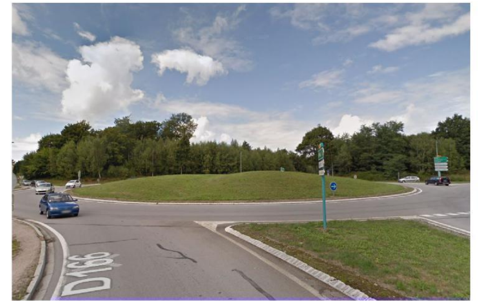
Extrémité Est du contournement, le rond-point d'Uxegney
