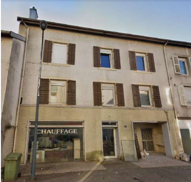
Photo 1 : 4 logements vacants au 26 rue de la Moselle (source : 2 cellules IAD) d'après le fichier. En réalité, 9 logements réhabilités et occupés.
