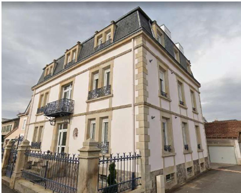
Immeuble rue de Beaulieu, classé comme vacant, mais logements réhabilités pour la location
