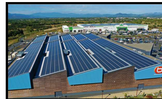
sur toitures tertiaires ou industrielles
