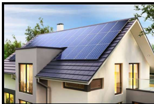
Photovoltaïque sur « petites » toitures
